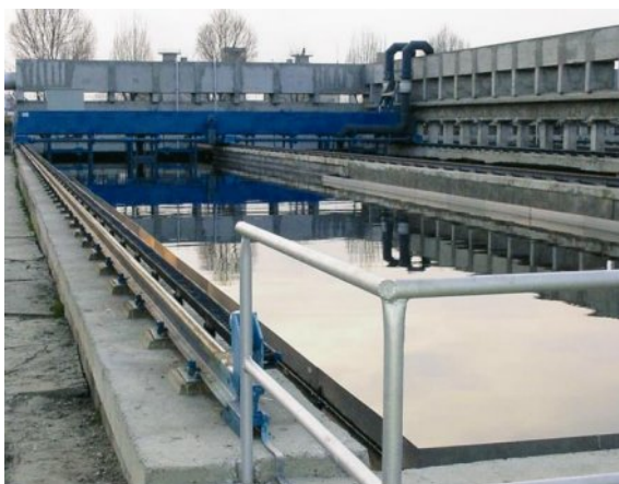
Figura 12.4 Clarificador rectangular (foto: D. Brdjanovic)
