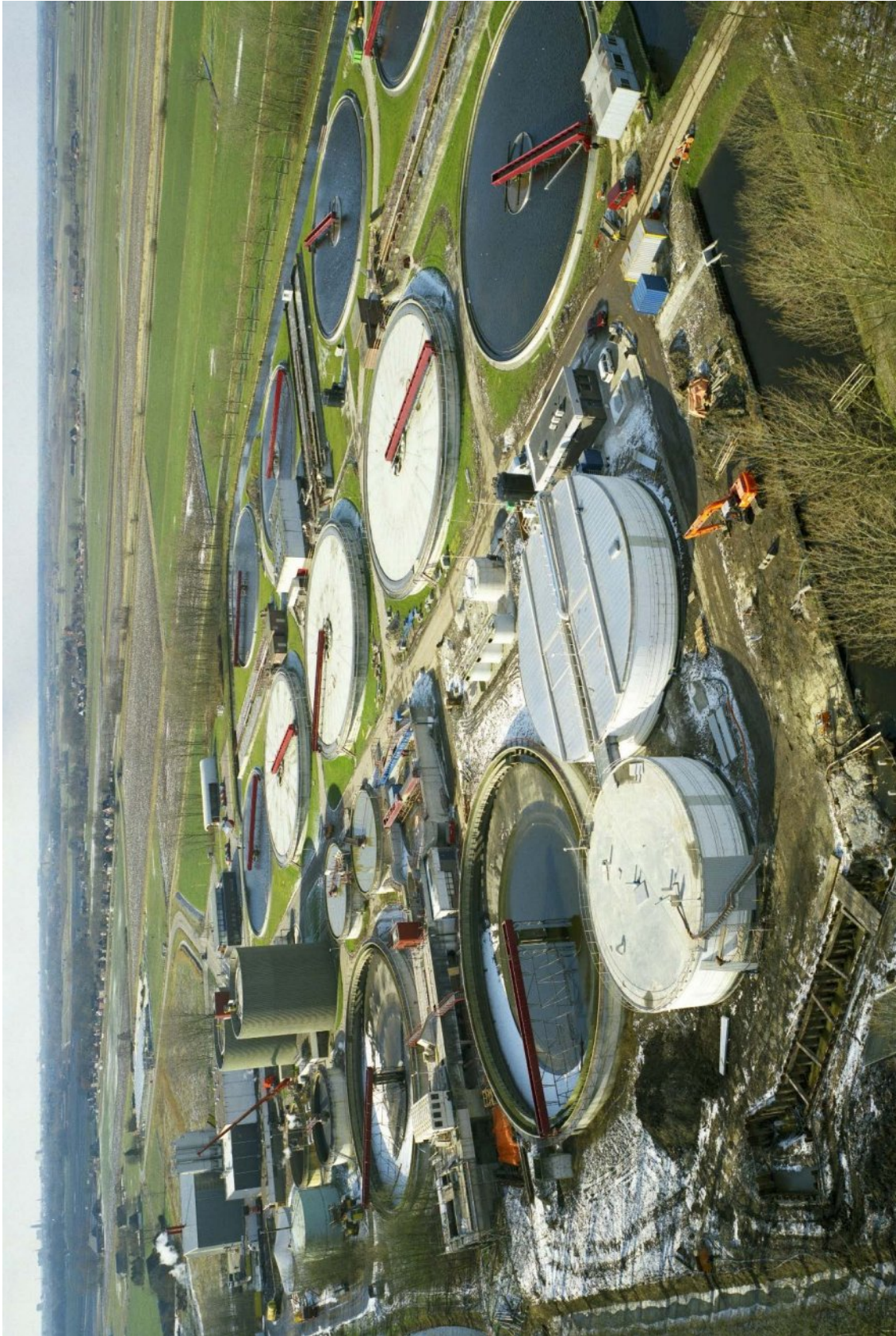
Premio obtenido (Premio IWA al Proyecto de Innovación, Europa 2008) en la PTAR Garmerwolde en los Países Bajos empleando el proceso SHARON® (dos reactores blancos en el frente; foto: Grontmij Nederland N.V.)
