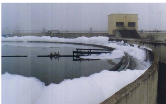
Figura 3.2 Los detergentes en altas concentraciones crean problemas en la operación de las plantas de tratamiento de aguas residuales. (foto: M. Henze)
