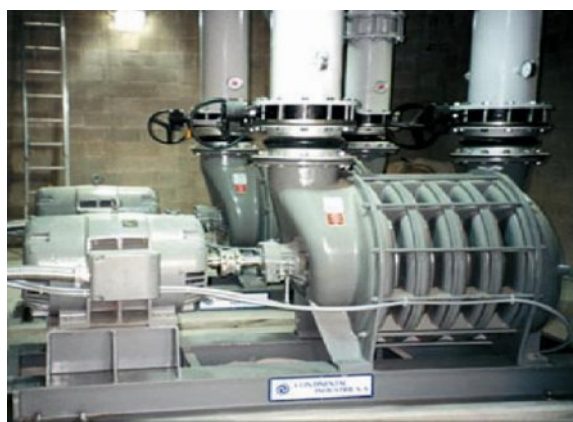
Figura 9.12 Sopladores centrífugos de una etapa (izquierda) y de múltiples etapas (derecha) (fotos: M.K. Stenstrom)
