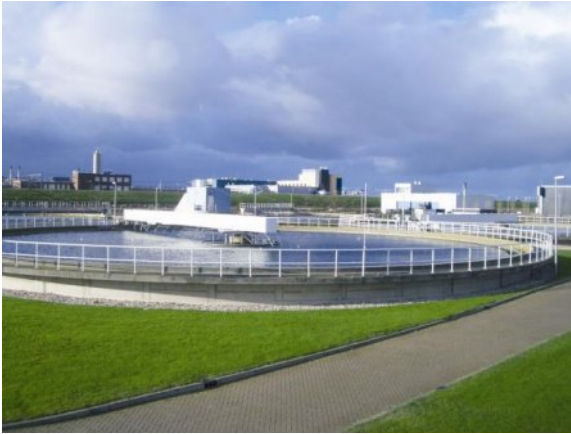
Figura 12.2 Clarificador circular (foto: D. Brdjanovic)
