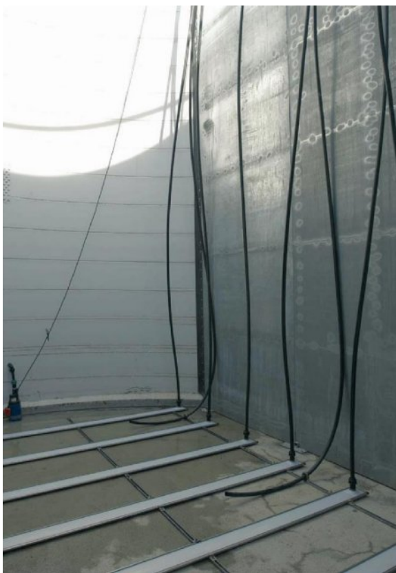
Figura 9.26 Difusores de poro fino (en este caso paneles de membrana) ubicados dentro de un tanque de 5 m de profundidad antes de llevar a cabo las pruebas en agua limpia (foto: M.K. Stenstrom)
