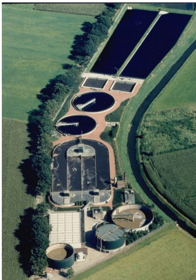
Aplicación a gran escala de la tecnología UASB: planta de tratamiento de aguas residuales de la industria cervecera de Bavaria en Leshout, Holanda. El reactor UASB se encuentra en frente del Carrusel (Imágen: J.B. van Lierpor cortesía de Bavaria N.V.)
