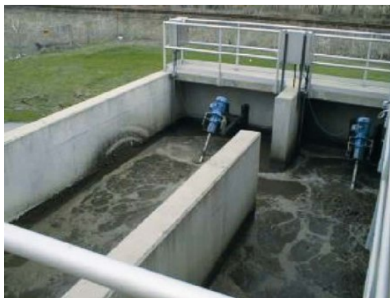
Figura 11.7 Selector Aerobio (foto: M.C.M. van Loosdrecht)
