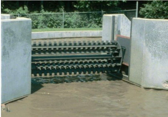
Figura 9.4 Dique de oxidación o carrusel (en la parte superior se muestra un esquema de flujo) equipado con mezcladores superficiales de cepillo durante un periodo de descanso (abajo a la izquierda) y durante su operación (abajo a la derecha). El eje del aireador está montado sobre rieles que permiten regular la energía proporcionada por el motor, así como también elevar el aireador por completo sobre la superficie libre del agua evitando obstruir el flujo del líquido durante las labores de mantenimiento o descanso (fotos: M.K. Stenstrom)
