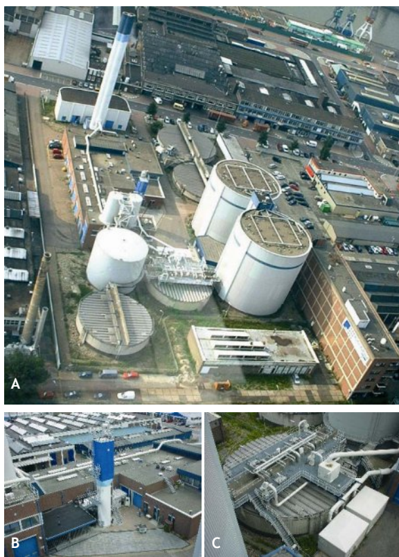
Figure 6.9 Vista aérea de las instalaciones de la PTAR Dokhaven (A) tratamiento de lodos y proceso Anammox, (B) proceso SHARON® (C) reactores vistos desde la parte algo del digestor de lodos (foto: Water Board Hollandse Delta)
