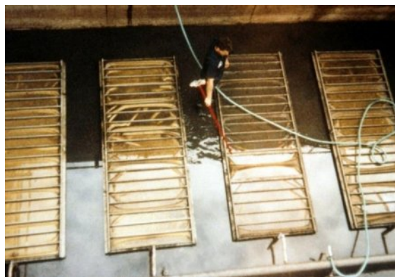
Figura 9.9 Ejemplos de instalaciones de difusores de poro fino ubicados en el fondo de dos tanques de aireación. A la izquierda, discos cerámicos. A la derecha, paneles de membrana (fotos: M.K. Stenstrom)
