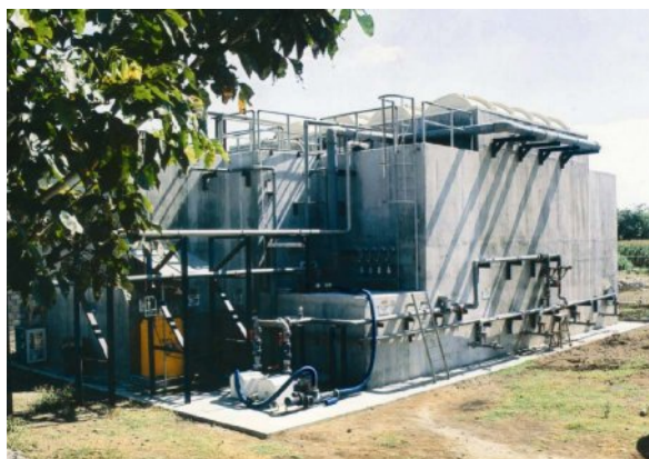
Figura 16.18 Instalaciones de UASB para el tratamiento de (A) agua residual proveniente de una fábrica de jugo de frutas en Bregenz, Alemania y (B) agua residual de una industria de lácteos en Indonesia (Imágenes: Paques B.V. y Biothane B.V. respectivamente)
