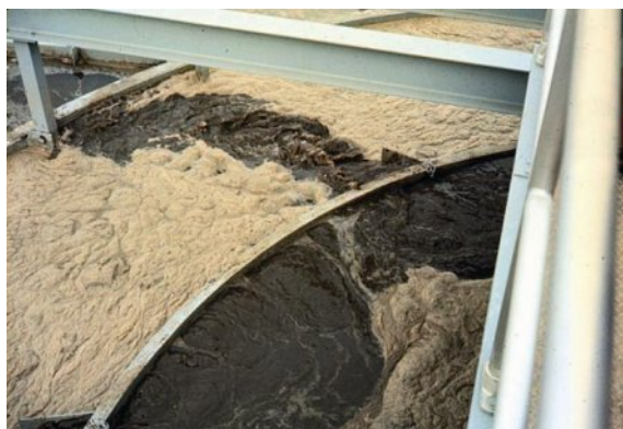
Figura 12.8 Nata en un clarificador (foto: Black y Veatch)
