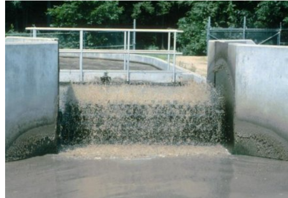
Figura 9.4 Dique de oxidación o carrusel (en la parte superior se muestra un esquema de flujo) equipado con mezcladores superficiales de cepillo durante un periodo de descanso (abajo a la izquierda) y durante su operación (abajo a la derecha). El eje del aireador está montado sobre rieles que permiten regular la energía proporcionada por el motor, así como también elevar el aireador por completo sobre la superficie libre del agua evitando obstruir el flujo del líquido durante las labores de mantenimiento o descanso (fotos: M.K. Stenstrom)
