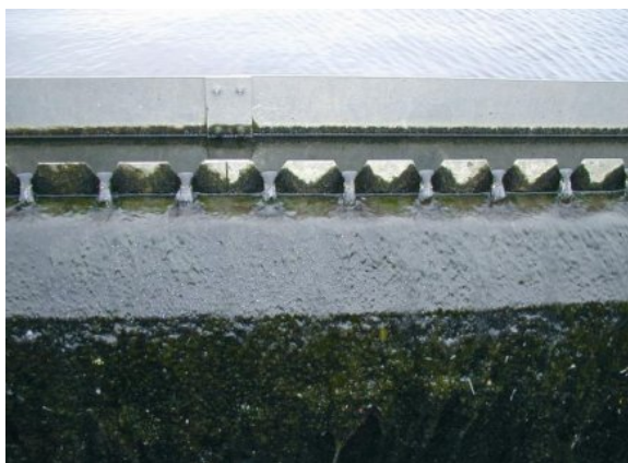
Figura 12.11 Algas en vertedores (foto: D. Brdjanovic)
