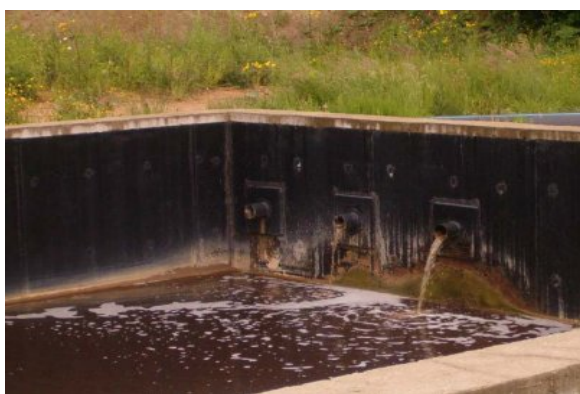
Figura 3.6 Captación y almacenamiento del lixiviado proveniente del relleno sanitario de Sarajevo en Bosnia y Herzegovina (Foto: F. Babić)
