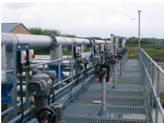
Figura 15.15 Detalle de la medición y el control del tanque de aireación en un sistema de lodos activados (foto: D. Brdjanovic)
