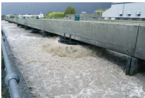
Figura 3.4 La aireación superficial en una planta de lodos activados genera aerosoles con una alta concentración de microorganismos. Esto representa un riesgo para la salud de los empleados de la planta de tratamiento y en algunos casos para los vecinos. (Foto: D. Brdjanovic)
